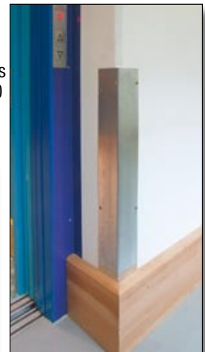
Detaillösung Eckschutz
