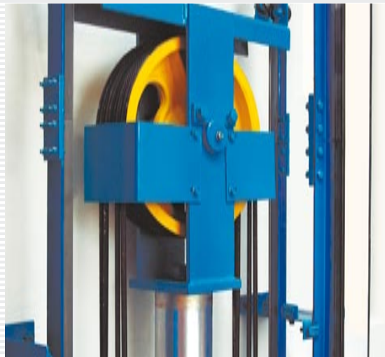
Seilhydraulik, Stempel im Schacht und Detail Umlenkrolle
