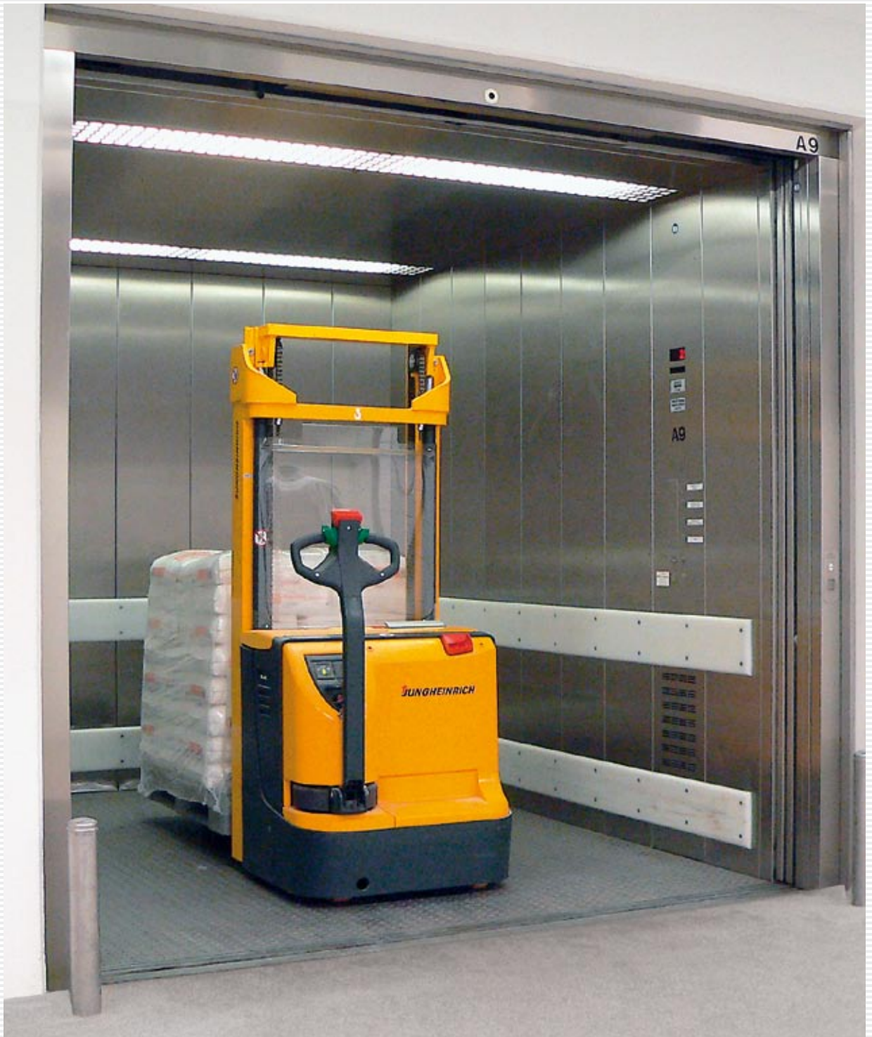
Lastenaufzug, Türbreite = Kabinenbreite, Boden: Riffelblech, Wände: V2A, doppelter Rammschutz, Decke mit integrierten Leuchtstoffröhren
