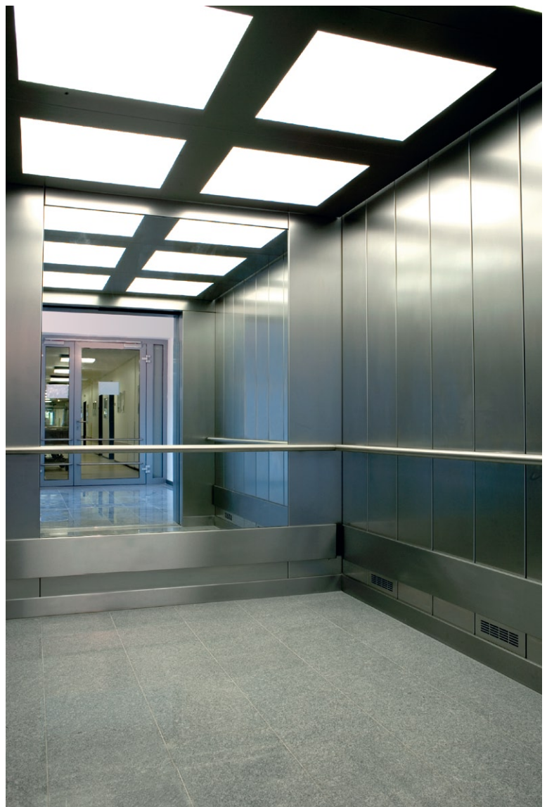
Bettenaufzug, Kabine: Edelstahl K240, Rammschutz, Handlauf und Decke mit grossen Beleuchtungsfeldern aus Plexiglas: Edelstahl, Bodenbelag: bauseits, Rückwand: Spiegel
