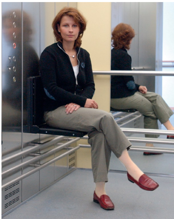
Klappsitz, 3-facher Rammschutz aus V2A, Handlauf
