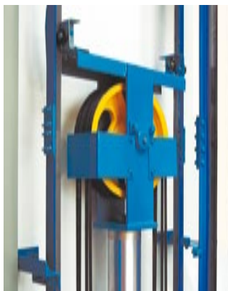
Seilhydraulik, Stempel im Schacht und Detail Umlenkrolle
