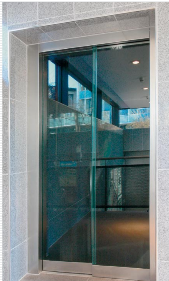
Schachttür, Glas, einseitig öffnend (neu)
