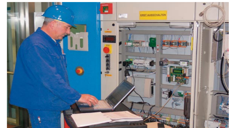
Steuerungsmodifikation vor Ort
