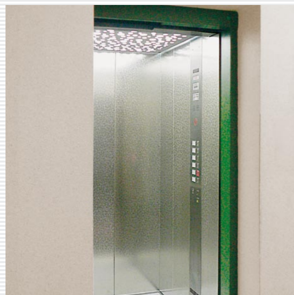
Aufzugskabine „nachher“ mit neuem Tableau, Decke, Auskleidung
