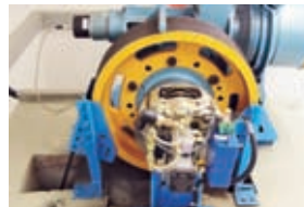
neuer Seilantrieb (Detail Bremse)
