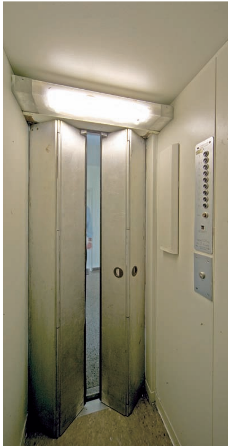
OSMA - Aufzug, Baujahr 1965, mit Falttüren, insgesamt 9 Haltestellen (K - 7)
