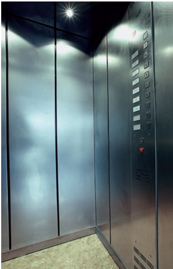
Aufzugskabine mit Edelstahl-Oberfläche
