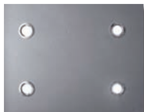
Decke mit Halogenspots
